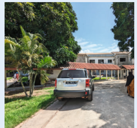
► Abb. 2 Blick auf den Hintereingang des Hauptgebäudes.
